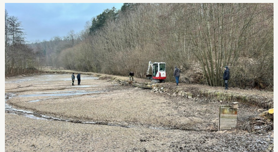
An den schlimmsten Stellen wurde der Damm verbreitert und abgestützt
