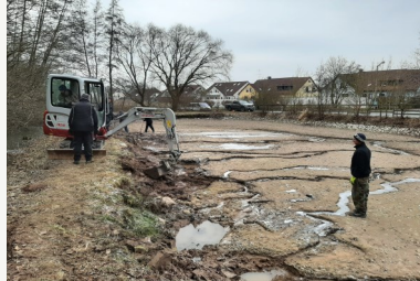
Durch den schmalen Damm waren die Arbeiten auch gefährlich
